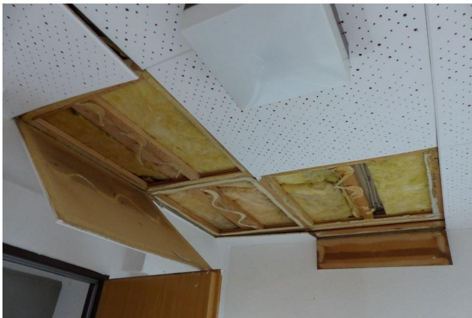
Abb. 8: Innenraum: Dämmung der Decke
